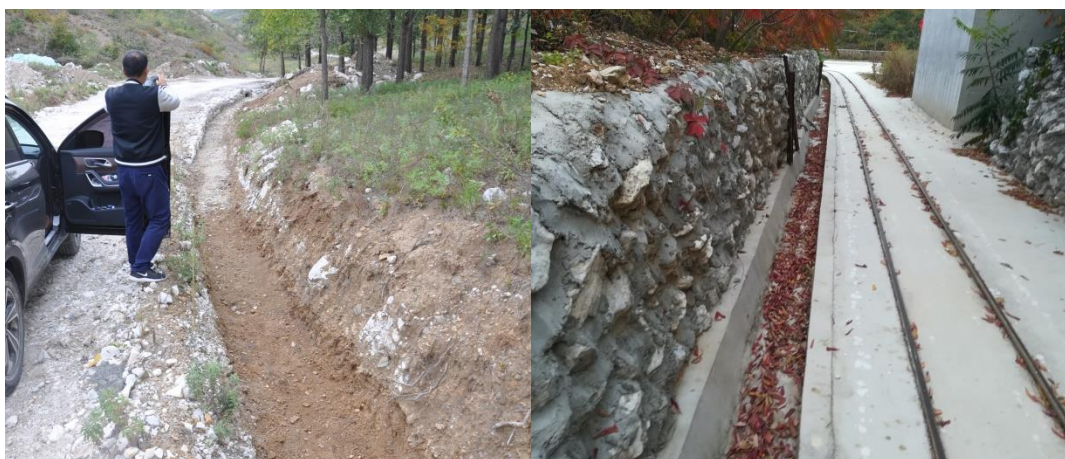
排水沟长度测量（2018. 9. 12）
